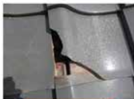
屋根材破損
