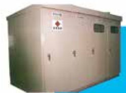
高圧受変電設備
